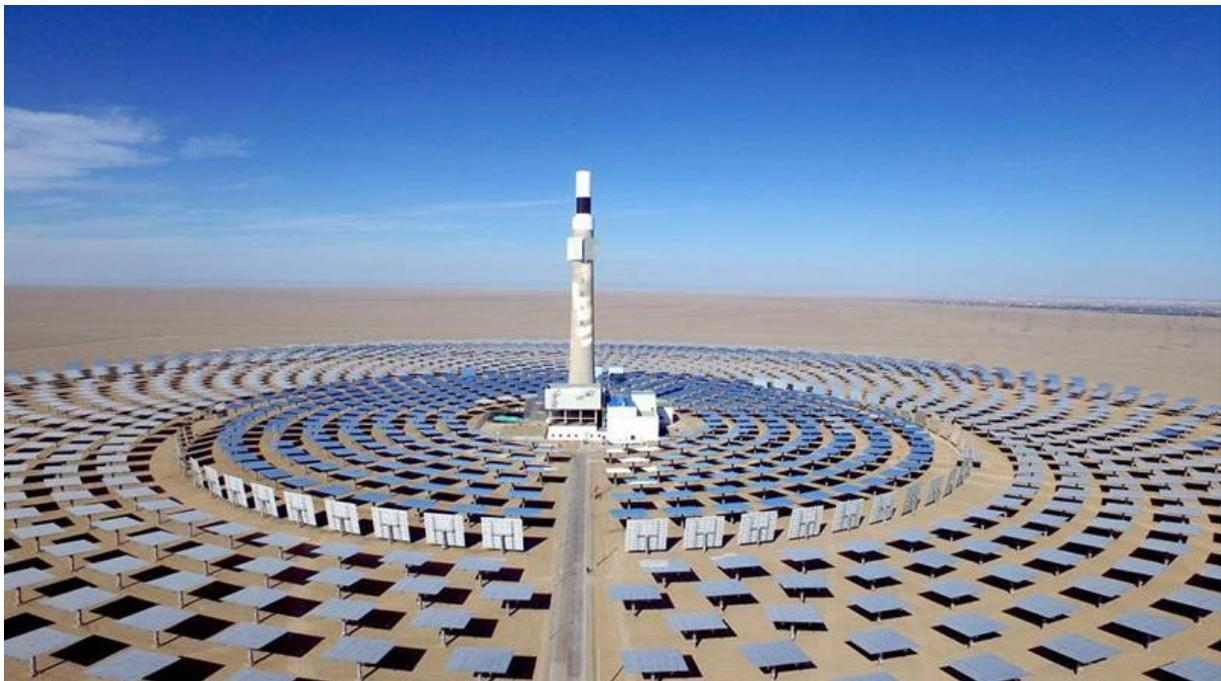
La centrale solaire thermique de Shouhang Dunhuang dans le désert de Gansu (Chine) a une puissance de 10 MW et une capacité de stockage de 15 heures lui permettant de fonctionner 24 heures sur 24. Photo Mathieu Baratier - EDF
